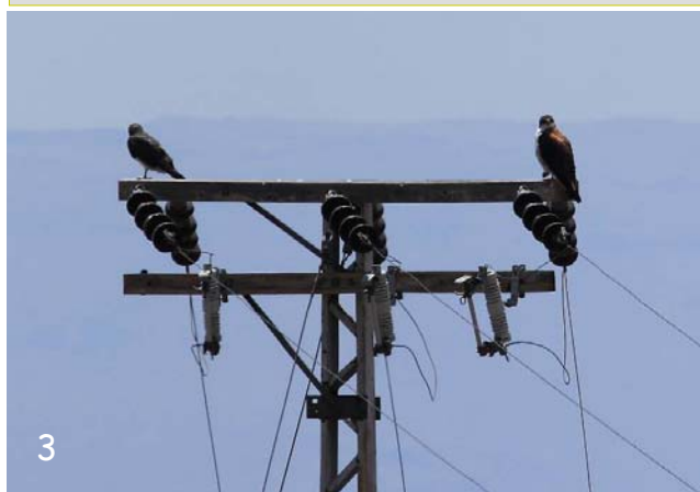
3 Aguiluchos ( Buteo polyosoma ) posados en línea de distribución de Farellones. En este caso no hay riesgo de electrocución puesto que los aisladores en cadena y largos otorgan suficiente distancia de los conductores. Foto P. Valenzuela
